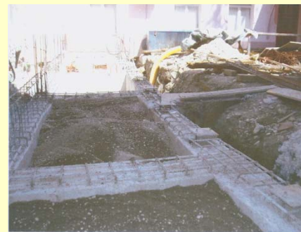
SI.3.6 – Gradnja temelja za spojni hodnik
