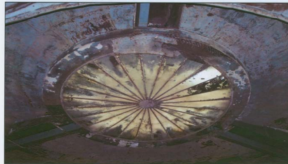
Slika 65. Vlačni prsten kao dio sustava odvodnje
