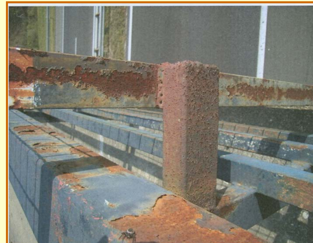
Slika 51. Spoj ograde i zaštitne ograde
