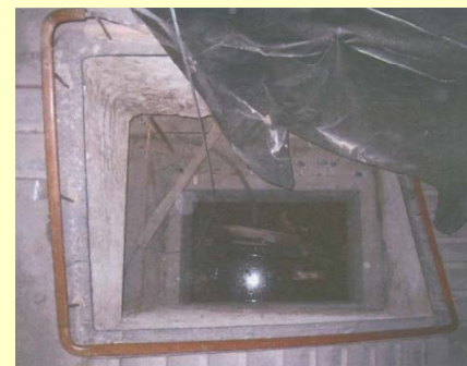
SI.3.2 – Mjesto ugradnje dizala
