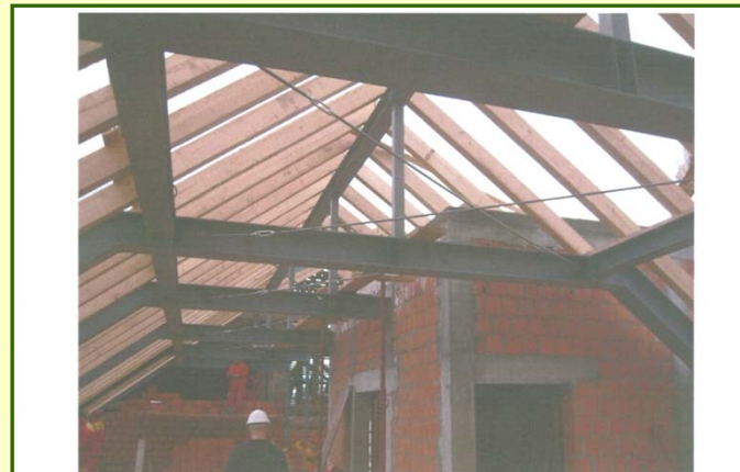
Sl.5.3 – Nova čelična nosiva konstrukcija krovijem
