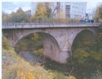
Slika 98. Nova kolnička konstrukcija s metalnom ogradom na mostu
