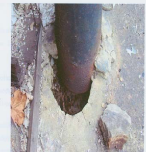
Slika 69. Spoj cijevi u sustav gradske kanalizacije
