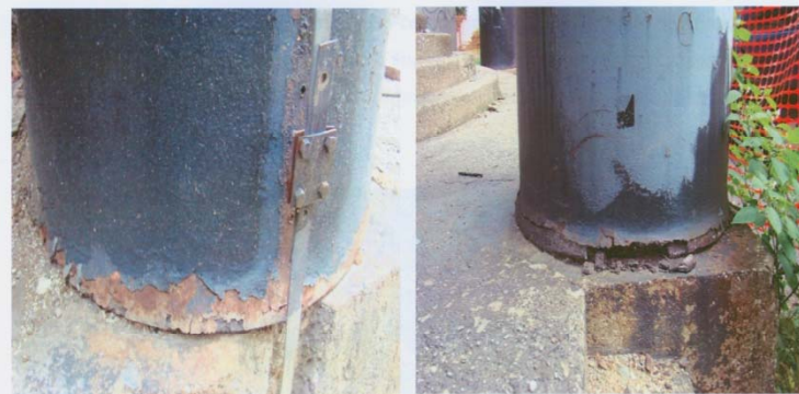
Slike 55. Spoj podloge i stupa
