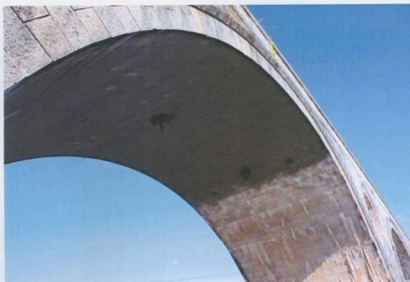
Slika 105. Uočena ptičja gnjezda na metalnim cijevima od drenažnog sustava ispunje na intradosima svodova
