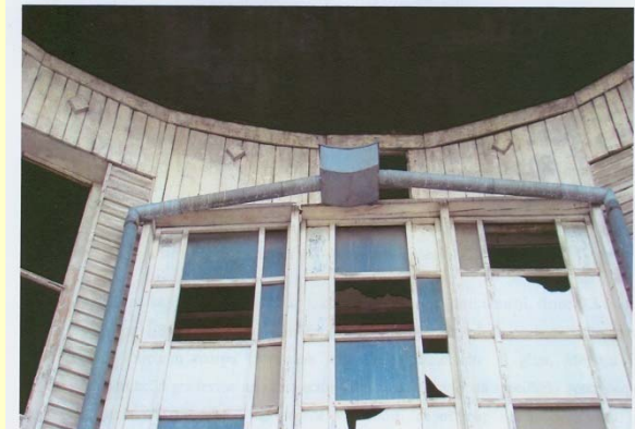
Slika 67. Sustav odvodnje
