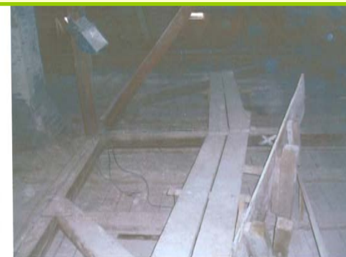
Sl.2.5 – Grede krovišta na tavanjskom prostoru
